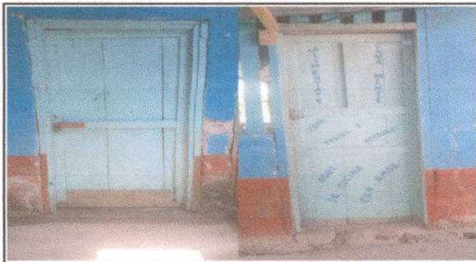
Foto 3. Sustrucción de puertas de madera por metal
