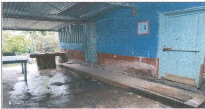
Foto 5. Sustrucción de pinturas en paredes
