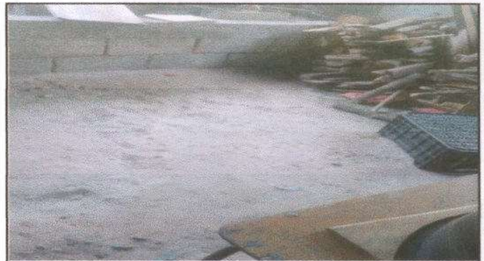
Foto 4. Sustrucción de piso de concreto
