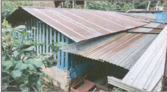
Foto 1. Sustrucción de lámina por lámina troquelada Aluzinc
