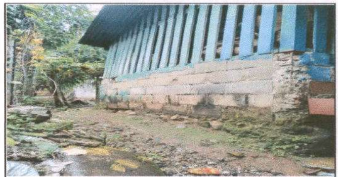
Foto 6. Sustrucción de muro perimetral
