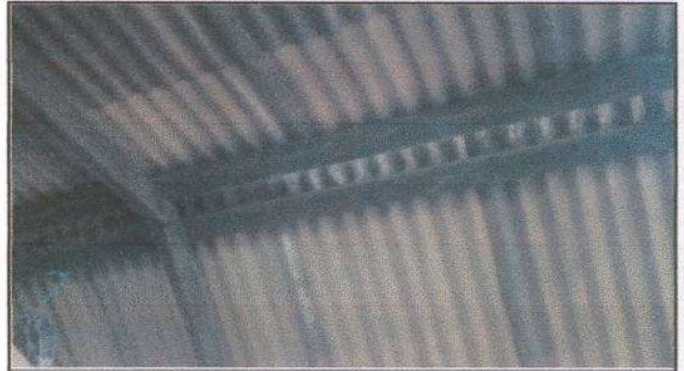
Foto 2. Sustrucción de estructura de madera por metal
